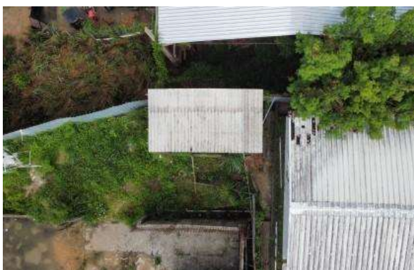
Foto 02 – Imagem do trecho instável do talude com indicação das salas de aula anexas.
